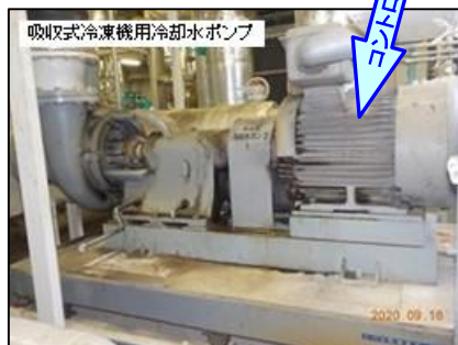
① 吸収式冷凍機用冷却水ポンプ
