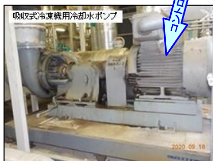
① 吸収式冷凍機用冷却水ポンプ
